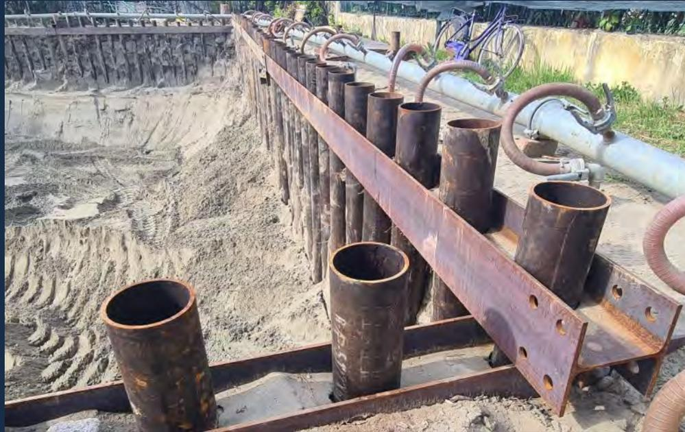
Il sistema Modulare di **Geonord wellpoint®** è flessibile ed economico, ha i vantaggi di un palancolato metallico infisso a pressione, Silent Piling, a poco più del prezzo di un palancolato infisso con vibroinfissore.
