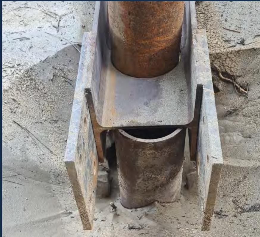
Peculiarità della **Berlinese Modulare ad Idrogetto** è di ottenere una paratia in assenza completa di percussione, trivellazione o vibrazione del terreno. I pali sono infissi nel terreno grazie all'azione di allentamento prodotta sulla punta del palo dalla pressione, controllata, esercitata dall'acqua spinta all'interno del palo stesso.
