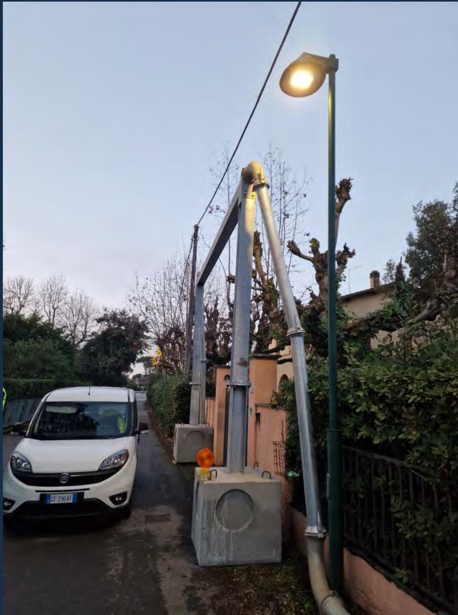
I portali di **Geonord wellpoint®** sono progettati e calcolati per il passaggio di tubazioni di vario diametro nel rispetto delle vigenti norme in ambito di circolazione stradale.
