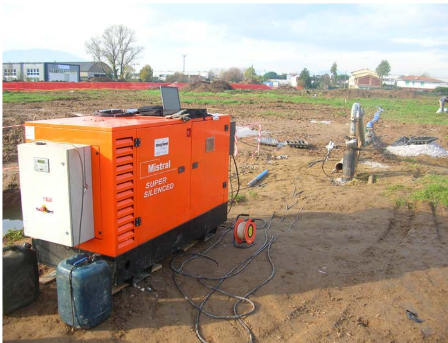
Strumentazione utilizzata per una prova di portata con pozzo indagine, prova con pozzo e prova con impianto wellpoint.
