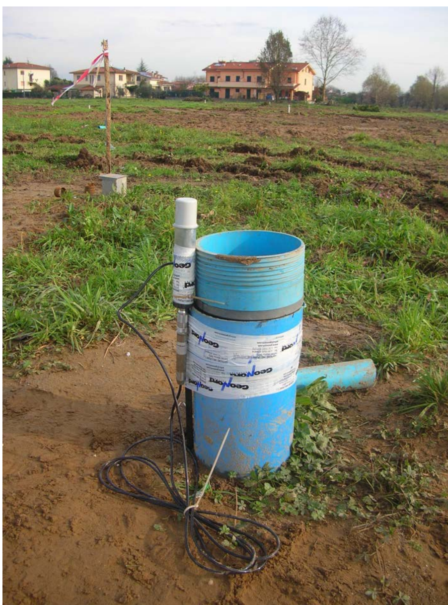
Particolare del piezometro con datalogger collocato all'interno di un piezometro di controllo
