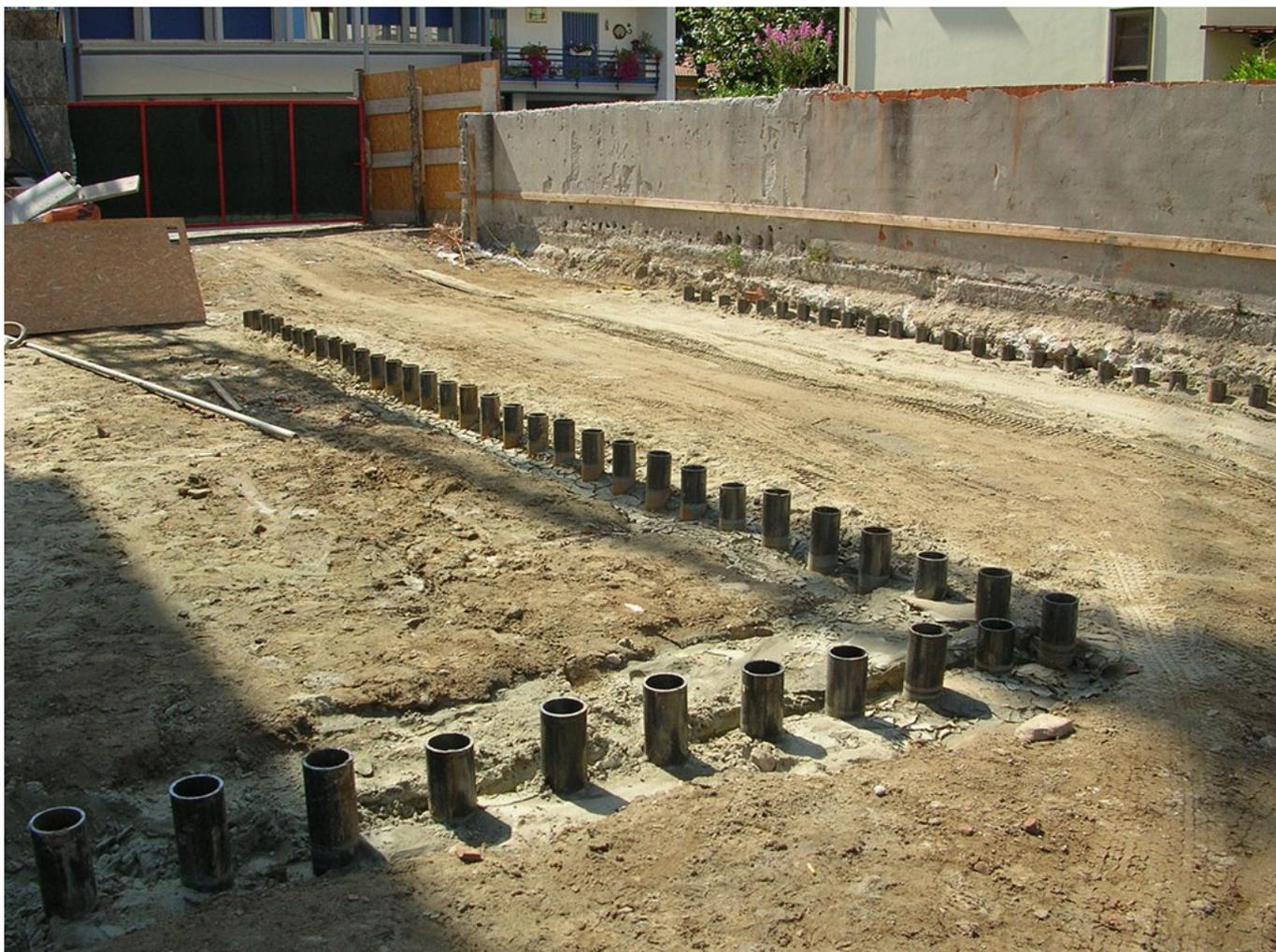
Particolare di una fila di pali installati con tecnica ad idrogetto.
