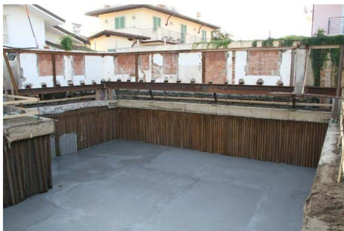
Il diametro dei pali da utilizzare ed il loro spessore sono calcolati in funzione dell'uso per il quali si rende necessaria la loro esecuzione. Generalmente vengono impiegati pali di diametro compreso tra mm.114 e mm.139 con spessori che variano da mm.5 a mm.8. La lunghezza dei pali è calcolata in funzione del carico e della profondità di scavo, si eseguono facilmente, con la tecnica ad idrogetto, pali fino alla profondità di c.a. 9/10 mt., generalmente vengono infissi pali da 6 mt., interi.
