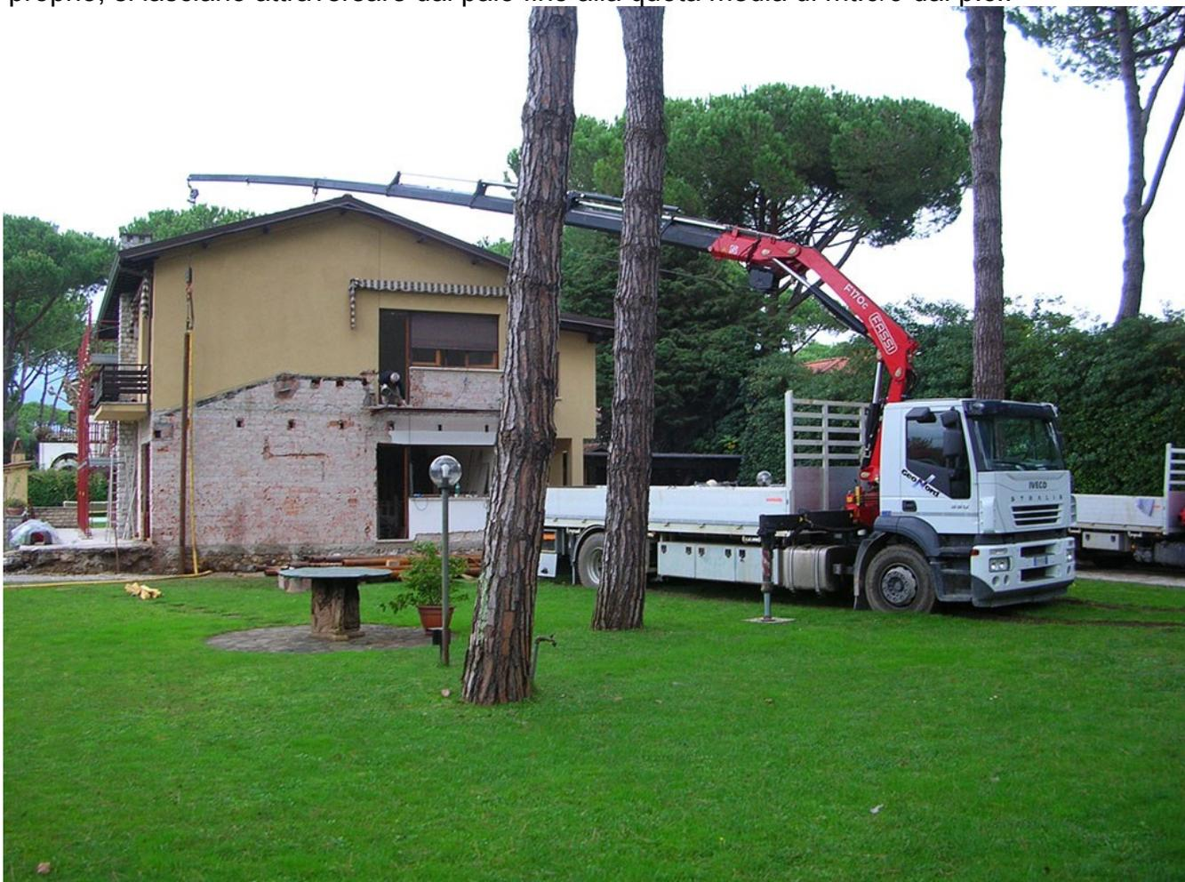
Il palo viene posizionato sulla verticale con l'utilizzo di un camion gru munito di verricello, una volta inserito nelle guide poste a terra inizia l'operazione di pompaggio dell'acqua.
