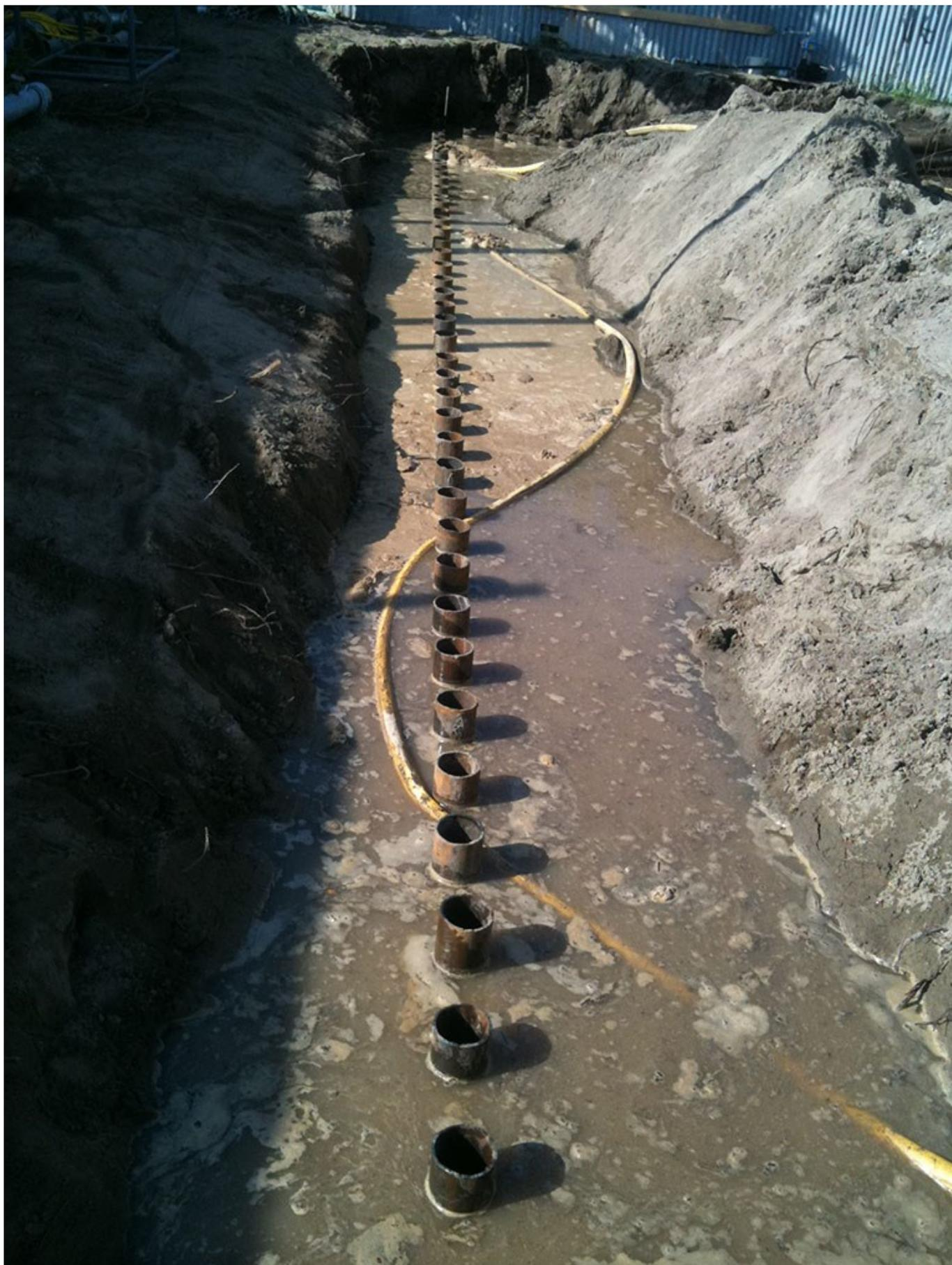
Particolare di una fila di pali installati con tecnica ad idrogetto.
