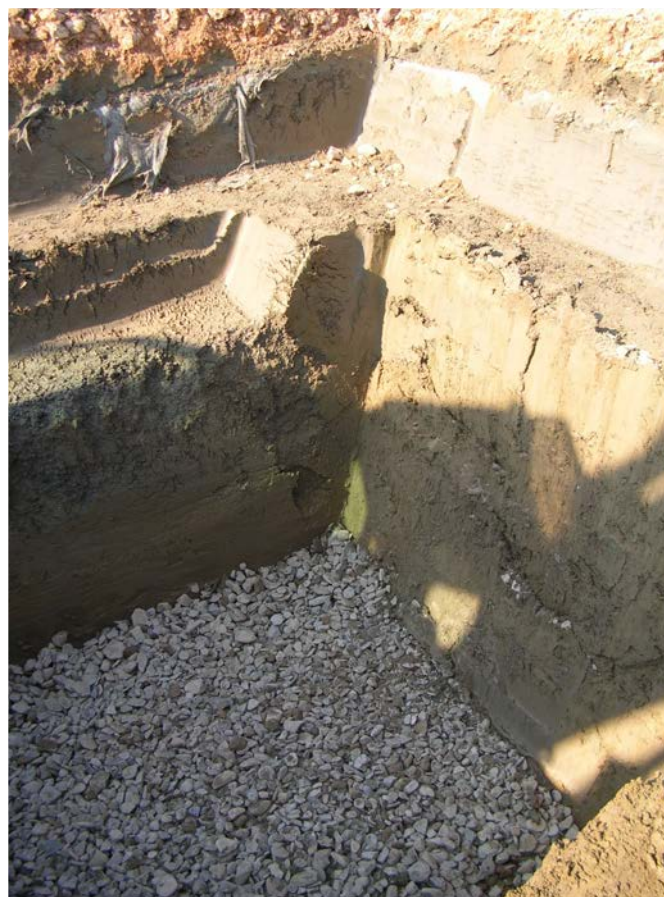
Inghiaio del fondo dello scavo.
