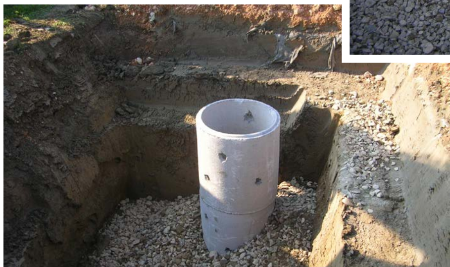
Inghiaio del fondo dello scavo.
