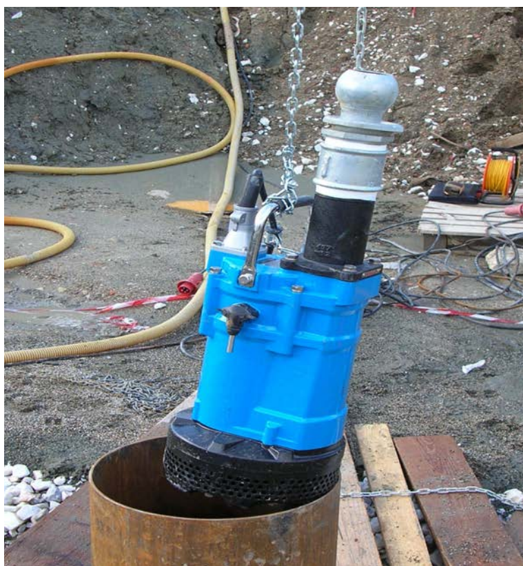
Pompa di media portata installata all'interno di pozzi in acciaio.
