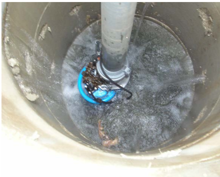
Pompa di grossa portata installata all'interno di pozzi con anelli in cls.
