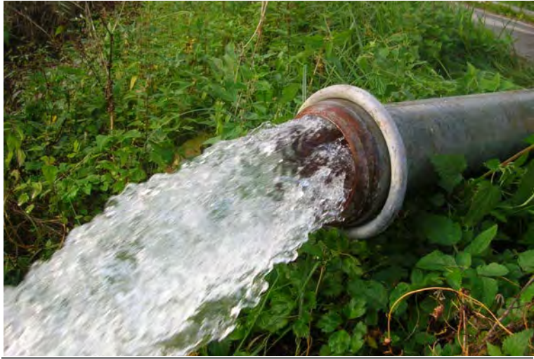
Particolare dell'uscita dell'acqua dalla tubazione di scarico
