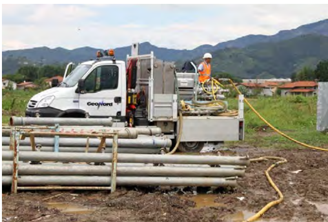
Fase di ispurgo dei wellpoint con pompa Jetting
