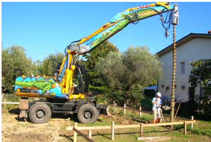
Esecuzione del foro con trivella oleodinamica
