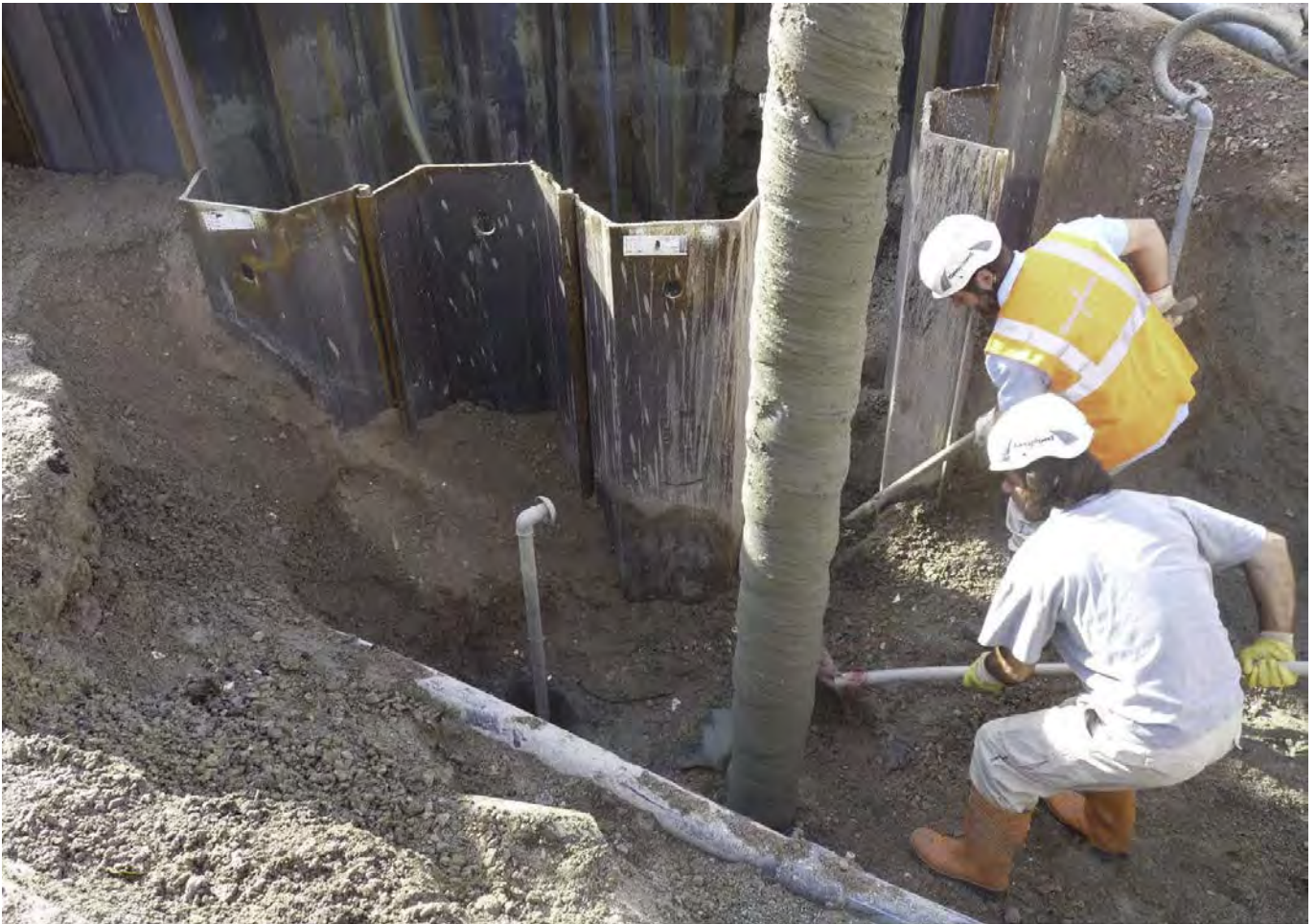
Fase di perforazione eseguita con trivella oleodinamica
