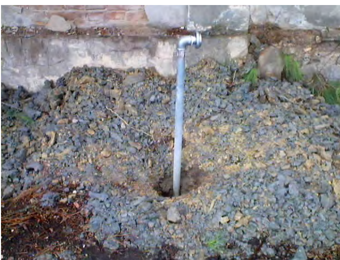
Pulizia del preforo dai materiali di perforazione
