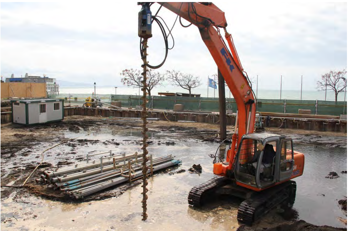
Fase di perforazione eseguita con trivella oleodinamica
