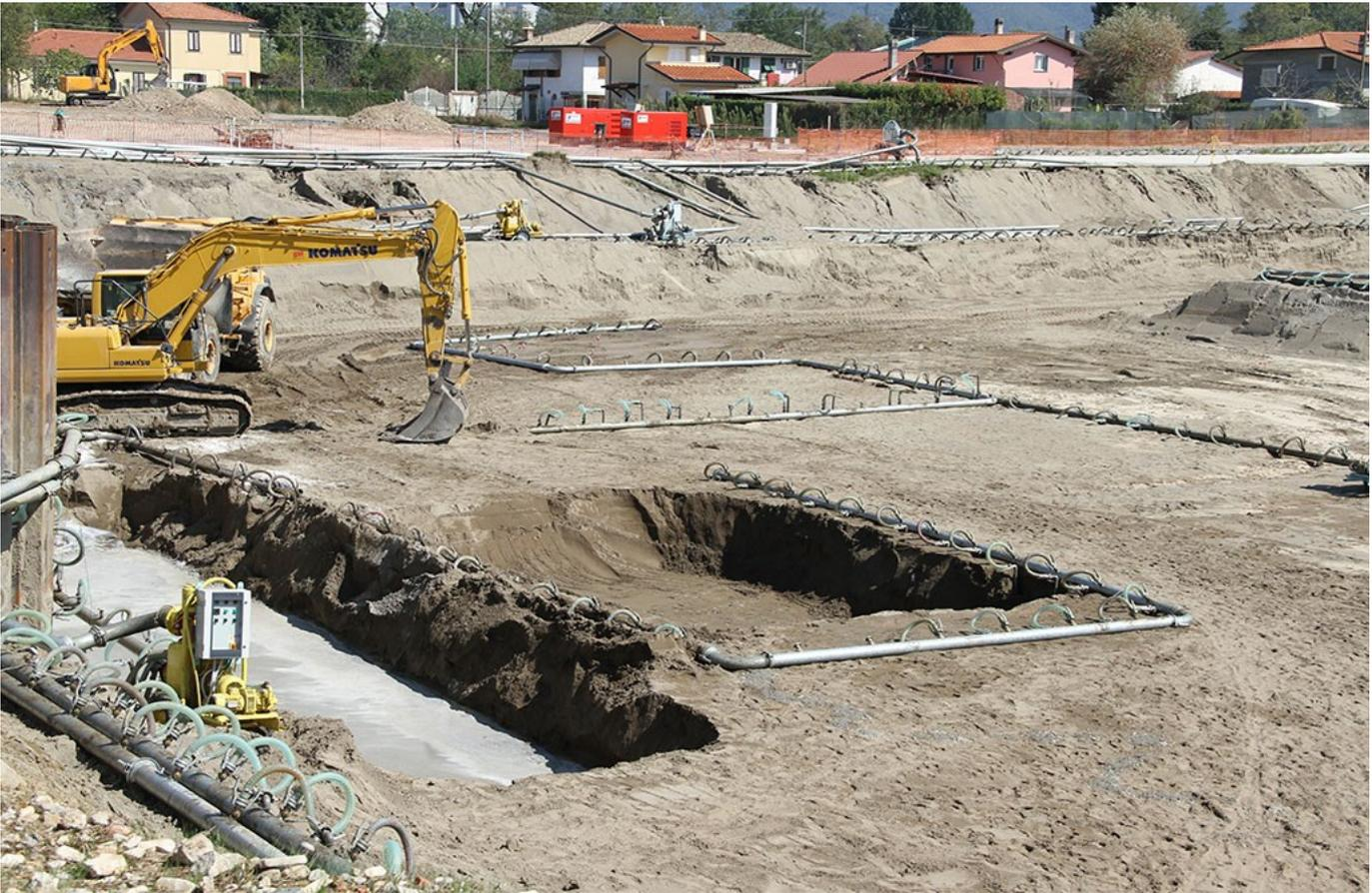
Il **sistema wellpoint** è una delle tecniche di dewatering utilizzabile per l'abbassamento controllato di una falda acquifera, generalmente una "Falda Freatica", il suo principio di funzionamento è caratterizzato dalla pressione negativa che la pompa, attraverso tutte le tubazioni, esercita alla quota dei filtri di aspirazione posti nel sottosuolo.
