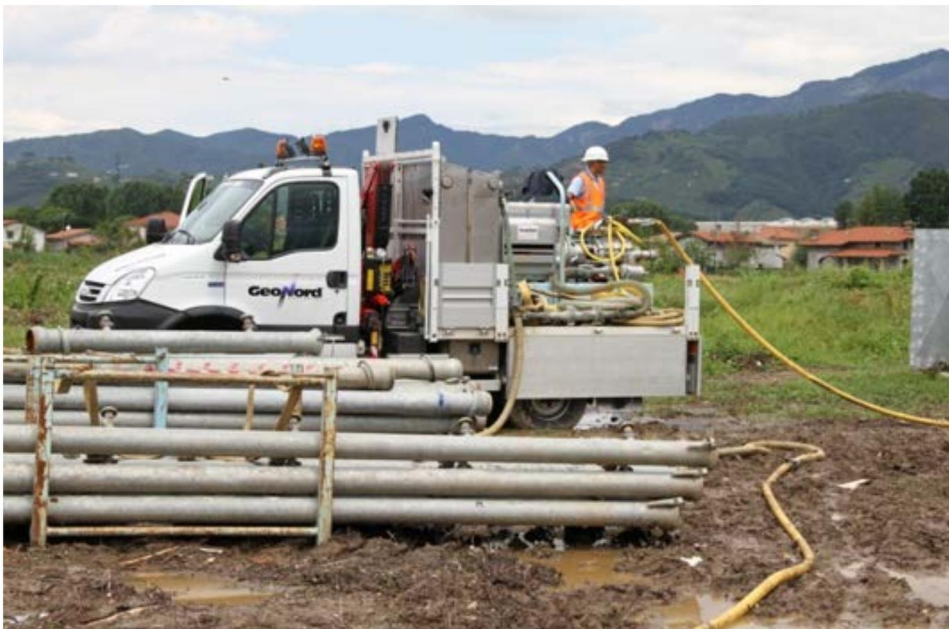
Installazione di un impianto wellpoint con tecnica ad Idrogetto
