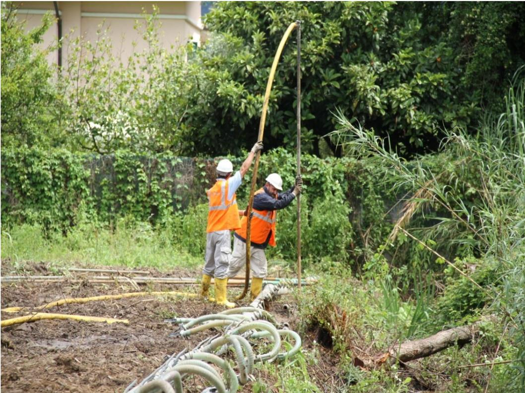
L'installazione dei wellpoint è una tecnica manuale eseguita sempre da due operatori che si aiutano a vicenda nella disposizione del wellpoint sulla verticale e durante la discesa dello stesso nel sottosuolo.
