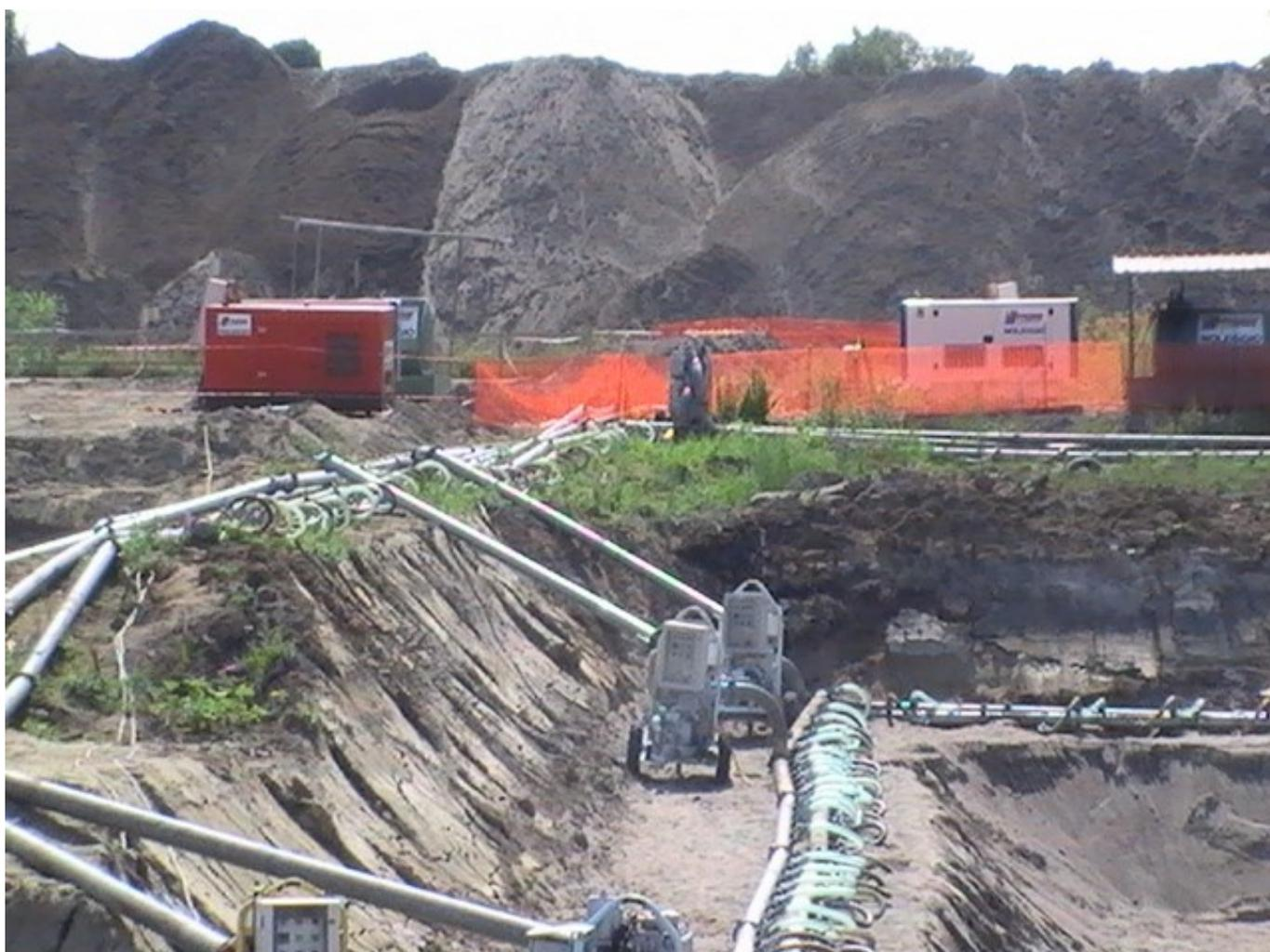
Impianto con Pompe Elettriche e Generatore Automatico di Emergenza
